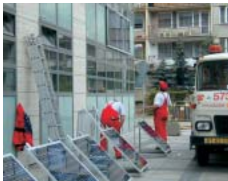
Montáž fotovoltaických panelů
