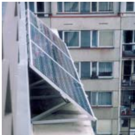
Realizace na střeše (orientace jih). Vzadu je obytný objekt stínící FV panely v přízemí.
