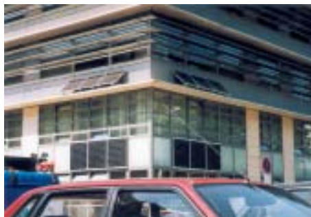
Panel Jih 45 je v horní části stíněn slunolamy, takže výkon do sítě nedodával celý panel!
