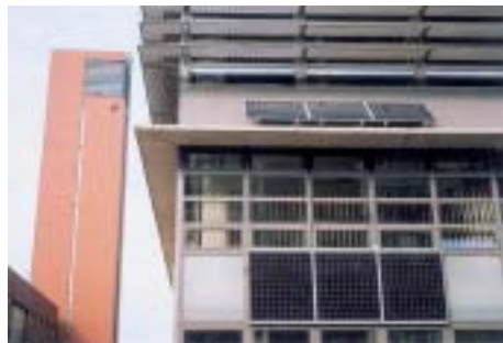
Východní pozice. Levé (jižní) panely nejsou vidět, odpoledne byly stíněny touto budovou.
