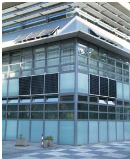
Fotovoltaické panely na budově PRE
