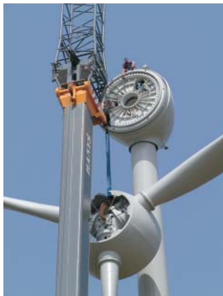
Instalace větrné elektrárny Enercon, E40/6. 44, Jindřichovice pod Smrkem
